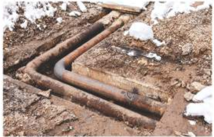
STEEL UNDERGROUND CONDUITS
